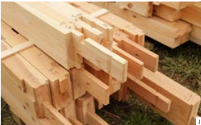
1: Prepared beams and sashigamois for the Kamogawa House 2: Assembling a kanawatsugi joint at the Kamogawa House 3: Log beam and pillar forming an aigaki-watariago/jyuhozo joint in the Kamogawa House | 1: Vigas y sashigamois preparados para la Casa Kamogawa 2: Ensamblaje de una kanawatsugi en la Casa Kamogawa 3: Viga de rollizo y poste de rollizo formando una junta aigaki-watariago/jyuhozo en la Casa Kamogawa | 1: Vigas e sashigamois preparados para a Casa Kamogawa 2: Montagem de uma junta kanawatsugi na Casa Kamogawa 3: Viga de tronco e pilar formando uma junta aigaki-watariago/jyuhozo na Casa Kamogawa (1-3: Ken Kusakari)
