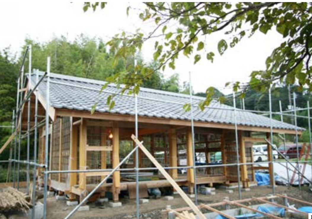
1: Construction of the tsuchikabe : lattice of bamboo laths at the Kamogawa House 2: Result of the first mud-coating process for tsuchikabe 3: Applying the second mud coating for tsuchikabe | 1: Construcción del tsuchikabe : celosías de tiras de bambú en la Casa Kamogawa 2: Resultado del primer proceso de revestimiento de barro para tsuchikabe 3: Aplicación de la segunda capa de barro para tsuchikabe | 1: Construção da treliça tsuchikabe de ripas de bambu na Casa Kamogawa 2: Resultado do primeiro processo de revestimento de barro da tsuchikabe 3: Aplicação da segunda camada de barro na tsuchikabe
