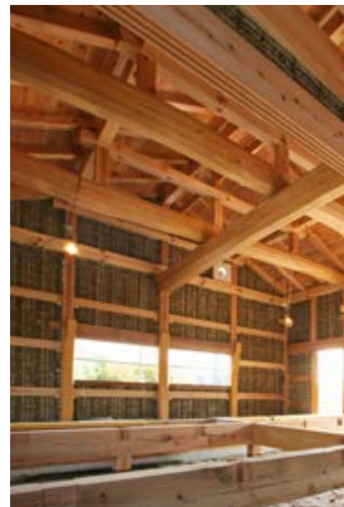
1: Construction of the tsuchikabe : lattice of bamboo laths at the Kamogawa House 2: Result of the first mud-coating process for tsuchikabe 3: Applying the second mud coating for tsuchikabe | 1: Construcción del tsuchikabe : celosías de tiras de bambú en la Casa Kamogawa 2: Resultado del primer proceso de revestimiento de barro para tsuchikabe 3: Aplicación de la segunda capa de barro para tsuchikabe | 1: Construção da treliça tsuchikabe de ripas de bambu na Casa Kamogawa 2: Resultado do primeiro processo de revestimento de barro da tsuchikabe 3: Aplicação da segunda camada de barro na tsuchikabe
