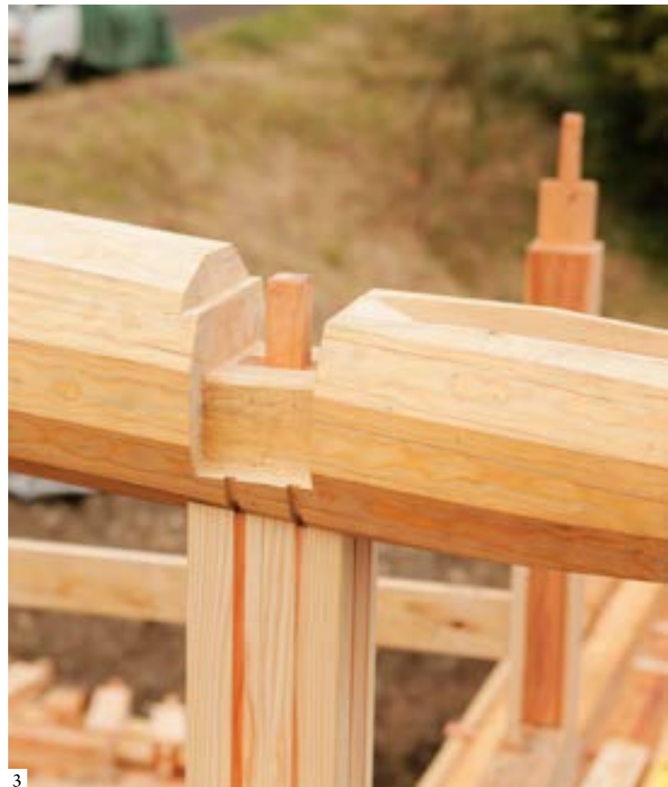
1: Prepared beams and sashigamois for the Kamogawa House 2: Assembling a kanawatsugi joint at the Kamogawa House 3: Log beam and pillar forming an aigaki-watariago/jyuhozo joint in the Kamogawa House | 1: Vigas y sashigamois preparados para la Casa Kamogawa 2: Ensamblaje de una kanawatsugi en la Casa Kamogawa 3: Viga de rollizo y poste de rollizo formando una junta aigaki-watariago/jyuhozo en la Casa Kamogawa | 1: Vigas e sashigamois preparados para a Casa Kamogawa 2: Montagem de uma junta kanawatsugi na Casa Kamogawa 3: Viga de tronco e pilar formando uma junta aigaki-watariago/jyuhozo na Casa Kamogawa (1-3: Ken Kusakari)
