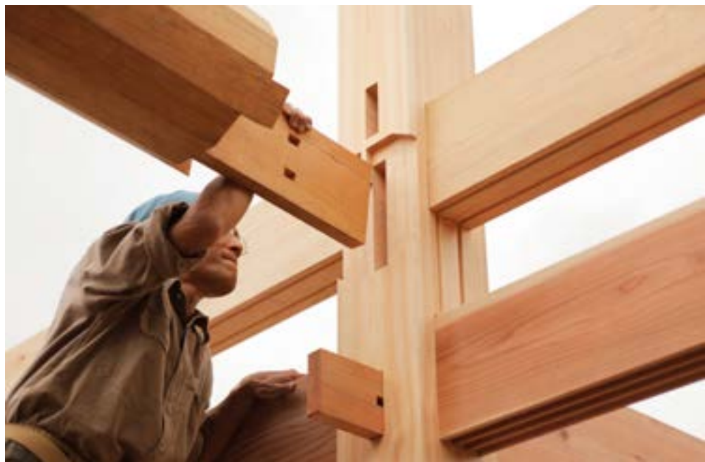
Erection of the framework of the Kamogawa House | Construcción del entramado de la Casa Kamogawa | Montagem da armação da Casa Kamogawa (Ken Kusakari)
