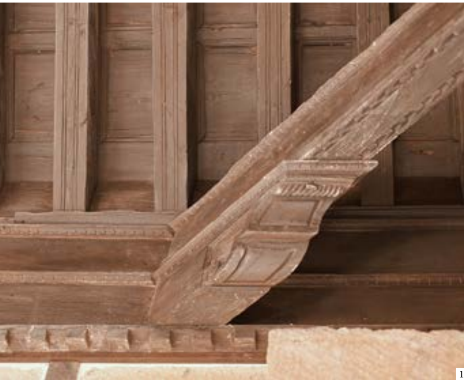
1: Detail of a coffered ceiling in the turret of the Palace of the Counts of Guadiana, Úbeda, Jaén, made out of recovered pieces and recycled beams | 1: Detalle del artesanado del torreón del Palacio de los Condes de Guadiana, Úbeda, Jaén 2: Artesonado del patio del Palacio de los Condes de Guadiana, Úbeda, Jaén, construido con maderas recicladas y piezas recuperadas | 1: Pormenores do artesanado do torreão do Palácio dos Condes de Guadiana, Úbeda, Jaén 2: Artesonado do pátio do Palácio dos Condes de Guadiana, Úbeda, Jaén, construído com madeira reciclada e peças recuperadas (Lucho Dávila)
