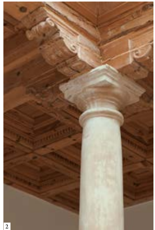
1: Detail of a coffered ceiling in the turret of the Palace of the Counts of Guadiana, Úbeda, Jaén, made out of recovered pieces and recycled beams | 1: Detalle del artesanado del torreón del Palacio de los Condes de Guadiana, Úbeda, Jaén 2: Artesonado del patio del Palacio de los Condes de Guadiana, Úbeda, Jaén, construido con maderas recicladas y piezas recuperadas | 1: Pormenores do artesanado do torreão do Palácio dos Condes de Guadiana, Úbeda, Jaén 2: Artesonado do pátio do Palácio dos Condes de Guadiana, Úbeda, Jaén, construído com madeira reciclada e peças recuperadas (Lucho Dávila)
