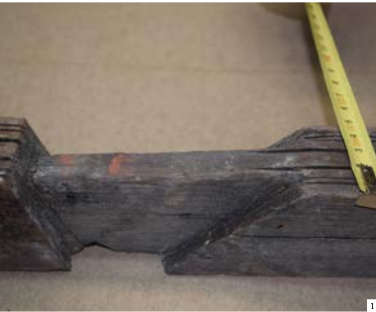
1. Slender rafter 2. Collar ties | 1: Par de pequeña sección 2: Nudillos | 1: Par de secção escassa 2: Níveis
