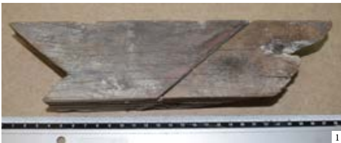
1: Patilla and barbilla birdsmouth for a wall plate 2: Salvaged structural member with polychrome remains in gramil grooves 3: Alfardón plank in almizate section 4: Board trimmed with plant motifs 5: Polychrome tabica board | 1: Patilla y barbilla en estribo 2: Pieza estructural recuperada con restos de policromía en los gramiles 3: Alfardón del almizate 4: Tablazón con una cenefa con motivos vegetales 5: Tabica policromada | 1: Patilla y barbilla no frechal 2: Peça estrutural recuperada com restos de policromia nos graminhos 3: Alfardón do almizate 4: Tabuleiro com uma sanefa com motivos vegetais 5: Tabica policromada
