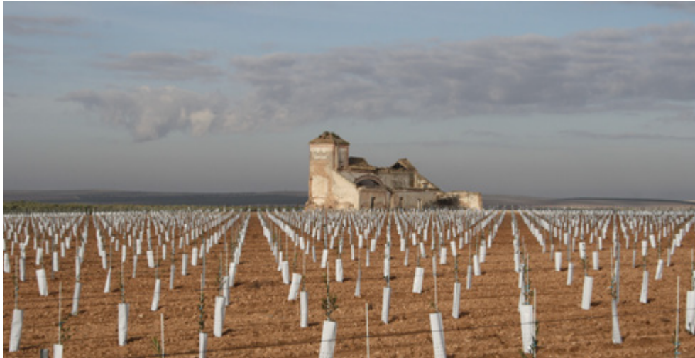
Molino aceitero de la Condesa en Écija, Sevilla. Para incrementar la superficie de olivar intensivo se han derribado recientemente las estructuras murarias del patio de esta almazara construida en la Edad Moderna
