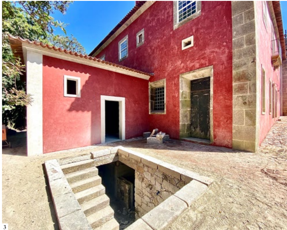
1: North wing before restoration 2: North wing during an archaeological excavation of the cellar and kitchen foundations 3: North wing after reconstruction of the kitchen volume, with new exterior steps to the cellar | 1: Ala norte antes de la intervención 2: Ala norte durante la intervención arqueológica, con la excavación del sótano y los cimientos de la cocina 3: Ala norte, tras la reconstrucción del volumen de la cocina y la apertura de la escalera exterior para el acceso al sótano técnico | 1: Ala norte antes da intervenção 2: Ala norte durante a intervenção arqueológica, para escavação da cave e fundações da cozinha 3: Ala norte, após a reconstrução do volume da cozinha, e abertura de escadaria exterior para acesso à cave técnica (1: PdS, Paulo dos Sousa)
