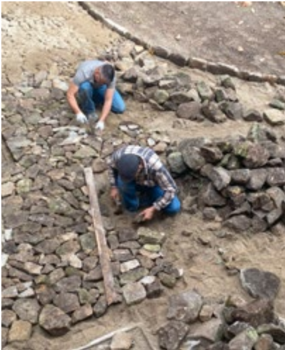
Restoration of granite elements with traditional building techniques | Recuperación de elementos de granito mediante el uso de técnicas tradicionales de construcción | Recuperação de elementos em granito, com recurso a técnicas tradicionais de construção
