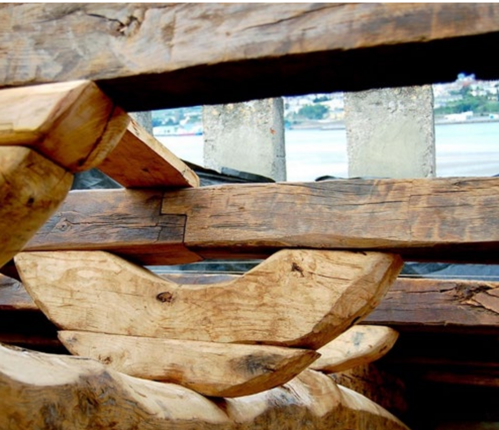
Footing solution for beams | Solución de zapata de cubierta | Solução de sapata
