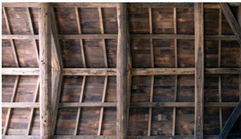
Roof structure over the central stairs | Armado de la cubierta de la escalera central | Estrutura da cobertura da escada central
