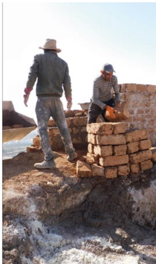
Construction process of the walls | Proceso de construcción de los muros | Processo de construção das paredes
