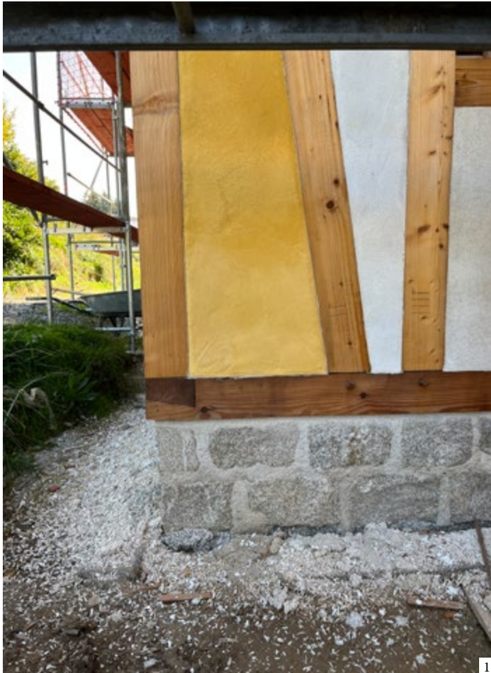
1: Lime plaster with natural pigment 2: Clay plastering | 1: Mortero de cal con pigmentos naturales 2: Revoco de arcilla | 1: Reboco de cal com pigmento natural 2: Reboco em argila
