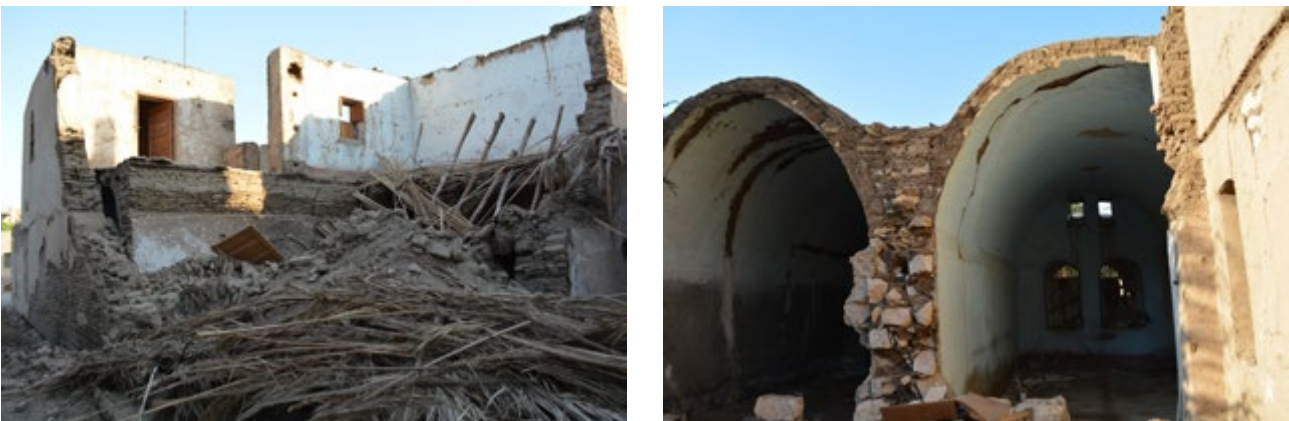
Figure 6: Deterioration and collapse of New Gourna buildings | Deterioro y derrumbe de los edificios de Nueva Gourna | Deterioração e colapso dos edifícios de Nova Gourna
