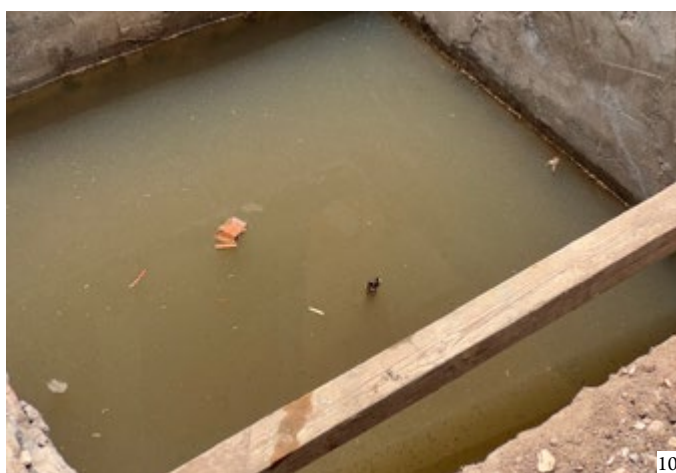
Figure 10: Groundwater in foundations | Agua subterránea en los cimientos | Água subterránea nas fundações
