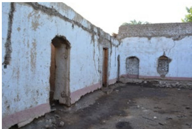
Figure 9: Erosion of foundations and walls due to groundwater seepage | Erosión de los cimientos y muros debido a la filtración de agua subterránea | Erosão das fundações e das paredes devido à infiltração de águas subterrâneas
