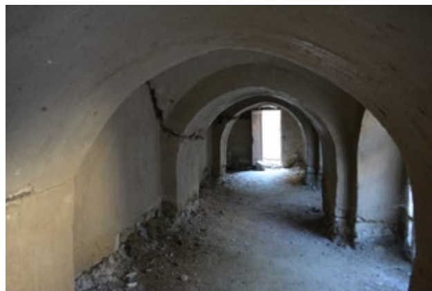
Figure 9: Erosion of foundations and walls due to groundwater seepage | Erosión de los cimientos y muros debido a la filtración de agua subterránea | Erosão das fundações e das paredes devido à infiltração de águas subterrâneas
