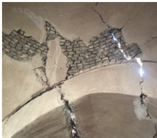
Figure 7: Lack of regular maintenance of New Gourna buildings | Falta de mantenimiento periódico de los edificios de Nueva Gourna | Falta de manutenção regular dos edifícios de Nova Gourna
