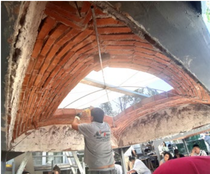
Figura 4. Bóveda extremeña, apoyada en arcos perimetrales, ejecutada por el maestro Máximo Portal
