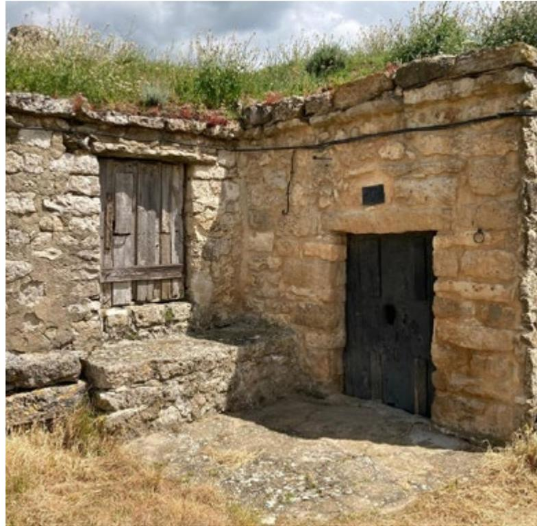
puede ser de lajas de piedra o de madera, recubierta por una capa de tierra vegetal. Uno de sus muros incluye una amplia abertura, utilizada para verter la uva directamente al interior, que se cierra con carpintería de madera con huecos para garantizar la ventilación.
