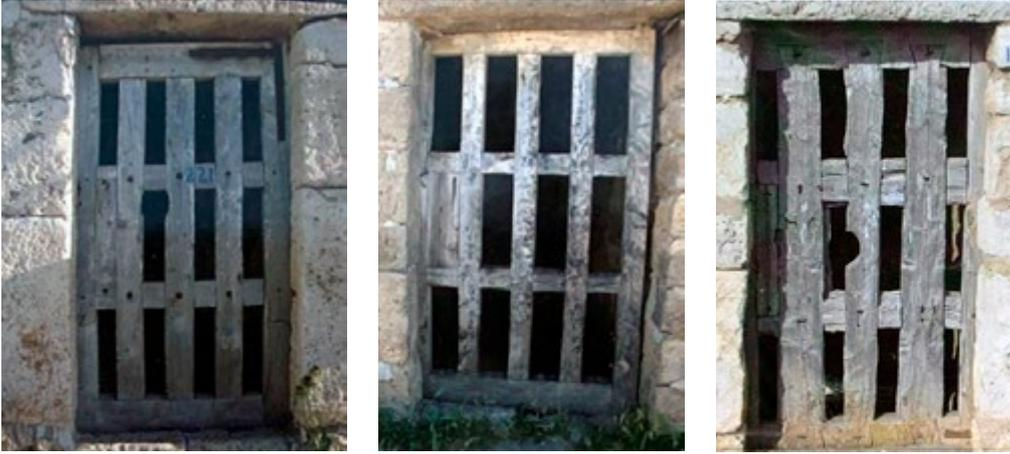
Figura 15: Algunas puertas de las Bodegas de Baltanás, con ejemplos de caja y espiga pasante y enclavijada. De izquierda a derecha: travesaño vertical a media madera recta / travesaño vertical a caja y espiga / travesaño vertical con cola de milano (Ayuntamiento de Baltanás)
