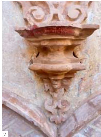
1: Support corbels for the eaves made by Miguel Ángel Balmaseda 2: Restoration of the brickwork in the spandrel 3: Process of cobbling and paving the open carriage porch | 1: Ménsulas de apoyo del tejeroz realizadas por Miguel Ángel Balmaseda 2: Restauración del ladrillo de la enjuta 3: Proceso de empedrado y enchinado del apeadero descubierto | 1: Mísulas de soporte do beiral executadas por Miguel Ángel Balmaseda 2: Restauro do tijolo na enjuta 3: Processo de empedramento e calçada da cocheira descuberta (1: Miguel Ángel Balmaseda 2: Sebastián Pérez Gómez 3: Urbipac)
