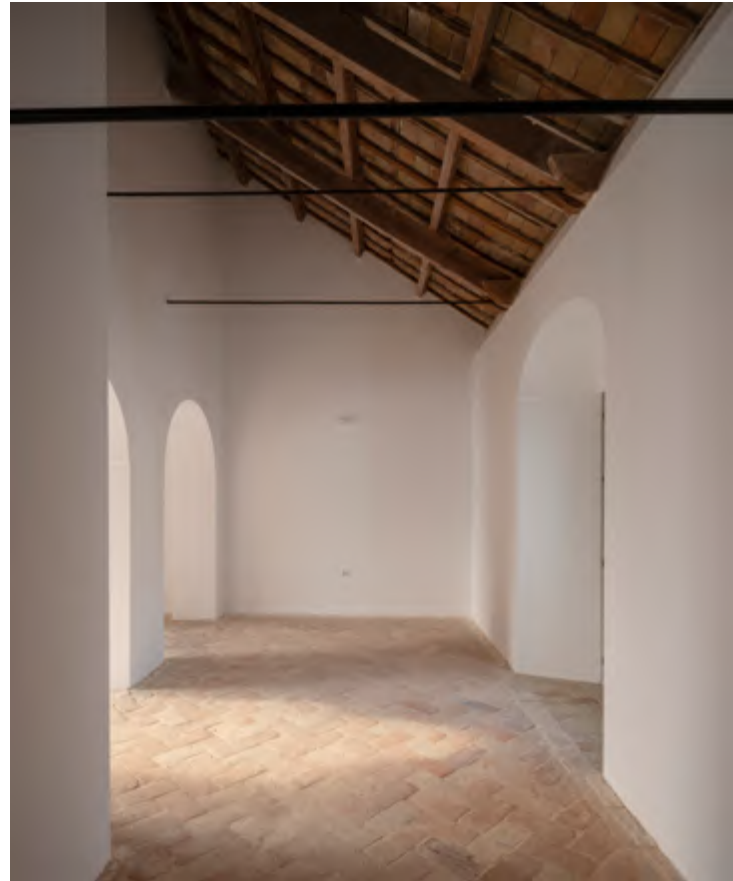
Granary with tie-beam trusses and “brick laid flat” roofing, with adjoining circulation spaces | Granero con cubierta de cerchas atirantadas y “ladrillos tendidos por tabla” y tránsitos anexos | Celeiro com cobertura de asnas atirantadas e “tijolos colocados por prancha” e circulações anexas (Fernando Alda)
