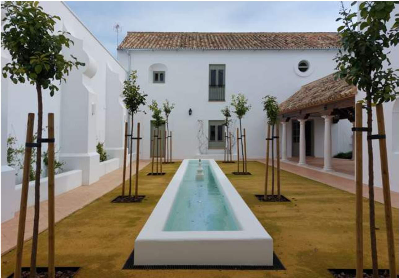
Courtyard of the irrigation channel with the new pavilion in the background and the connecting gallery between buildings on the right | Patio de la acequia con el nuevo pabellón al fondo y la galería de comunicación entre edificios a la derecha | Pátio da levada com o novo pavilhão ao fundo e a galeria de ligação entre edifícios à direita (Alejandro García Hermida)
