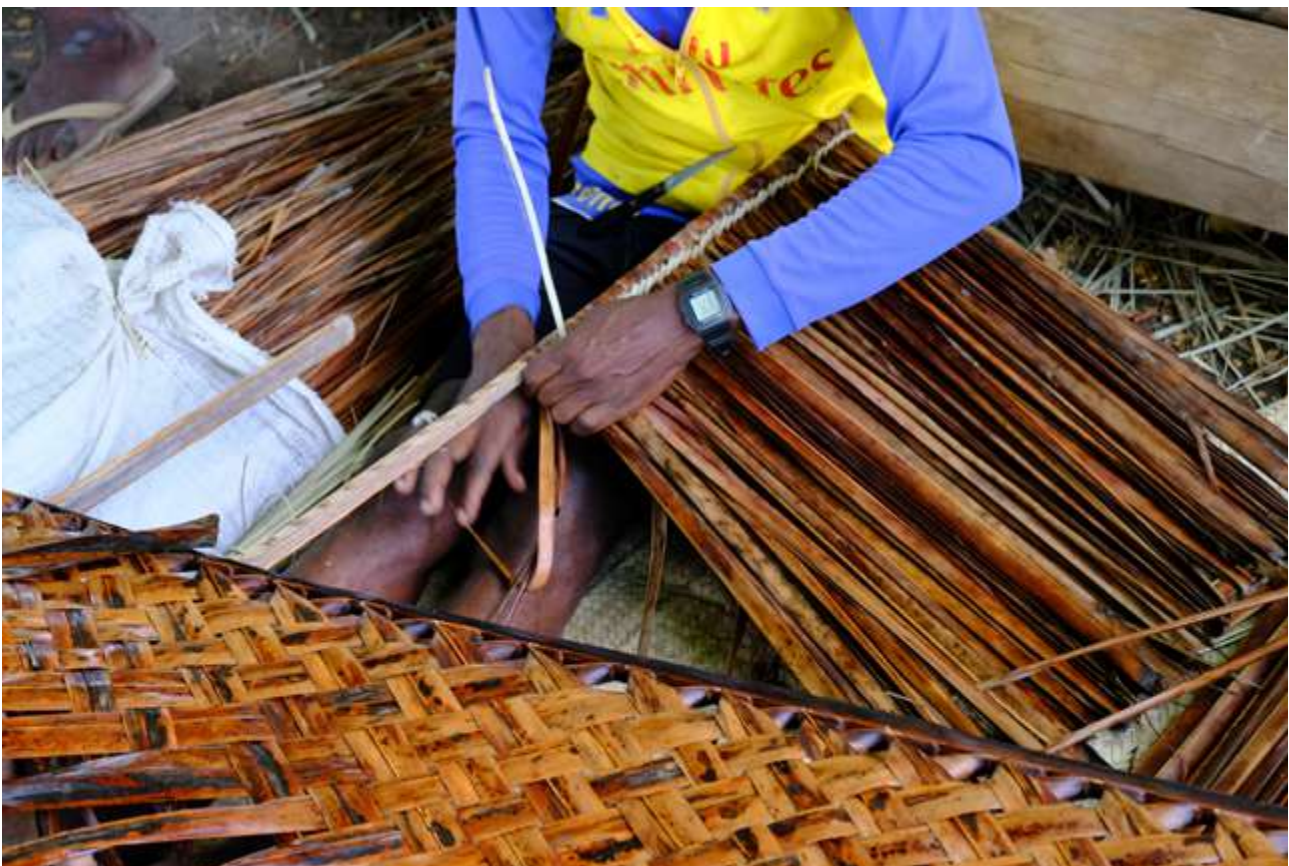
Assembly of makuti roofing piece | Montaje de pieza de makuti | Montagem de peça de makuti
