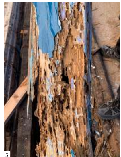
1: Interior of the cottage before restoration 2: Ridge beam of the cottage, displaced due to the lateral walls' collapse under the thrust of the rafters 3: Detail showing the widespread condition of termite-damaged wood | 1: Interior de la barraca antes de la restauración 2: Cumbre de la barraca, abierta por el desplome de los muros laterales bajo el empuje de los pares 3: Detalle del estado generalizado de la madera atacada por termitas | 1: Interior da cabana antes da restauração 2: Cumeeira da cabana, aberta pelo desabamento das paredes laterais sob o empuxo dos pares 3: Detalhe do estado generalizado da madeira atacada por térmitas
