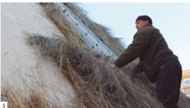
1: Process of exterior lining of the adobe walls—made of clay and rice straw—connected to the existing structure using cane notched in the form of a double harpoon and an earthen mortar enriched with lime 2: Layout of the wooden roof by the carpenter 3: Construction of the reed panel reinforced with canes 4: Application of the gypsum infill over the first reed layer of the roof slopes 5: Thatching process of the roof with bundles of marram grass 6: Detail of the roof thatching with bundles of marram grass | 1: Proceso de trasdosado exterior de los muros de adobe, fabricados con barro y paja de arroz, conectado al existente con cañas melladas en forma de arpón y con mortero de tierra enriquecido con cal 2: Replanteo de la cubierta de madera por el carpintero 3: Construcción del tablero de carrizo reforzado con cañas 4: Aplicación del rehenchido de yeso sobre el primer tablero de carrizo de los faldones de cubierta 5: Proceso de techado de la cubierta con haces de barrón 6: Detalle del techado de la cubierta con haces de barrón | 1: Processo de revestimento exterior das paredes de adobe, fabricadas com barro e palha de arroz, ligadas à estrutura existente com canas fendidas em forma de arpão e argamassa de terra enriquecida com cal 2: Marcação da cobertura de madeira pelo carpinteiro 3: Construção do painel de caniço reforçado com canas 4: Aplicação do enchimento de gesso sobre o primeiro painel de caniço das águas da cobertura 5: Processo de cobertura do telhado com feixes de carriço 6: Detalhe da cobertura do telhado com feixes de carriço (5: Rosaleny)
