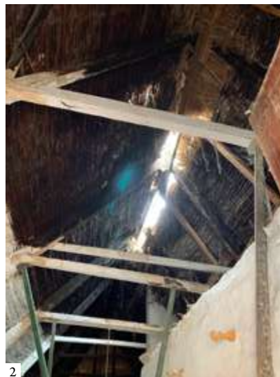
1: Interior of the cottage before restoration 2: Ridge beam of the cottage, displaced due to the lateral walls' collapse under the thrust of the rafters 3: Detail showing the widespread condition of termite-damaged wood | 1: Interior de la barraca antes de la restauración 2: Cumbre de la barraca, abierta por el desplome de los muros laterales bajo el empuje de los pares 3: Detalle del estado generalizado de la madera atacada por termitas | 1: Interior da cabana antes da restauração 2: Cumeeira da cabana, aberta pelo desabamento das paredes laterais sob o empuxo dos pares 3: Detalhe do estado generalizado da madeira atacada por térmitas
