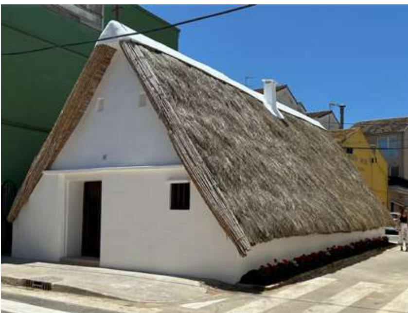
The cottage seen from the east, before and after the restoration | La barraca vista desde el este, antes y después de la intervención | A cabana vista desde o leste, antes e depois da intervenção
