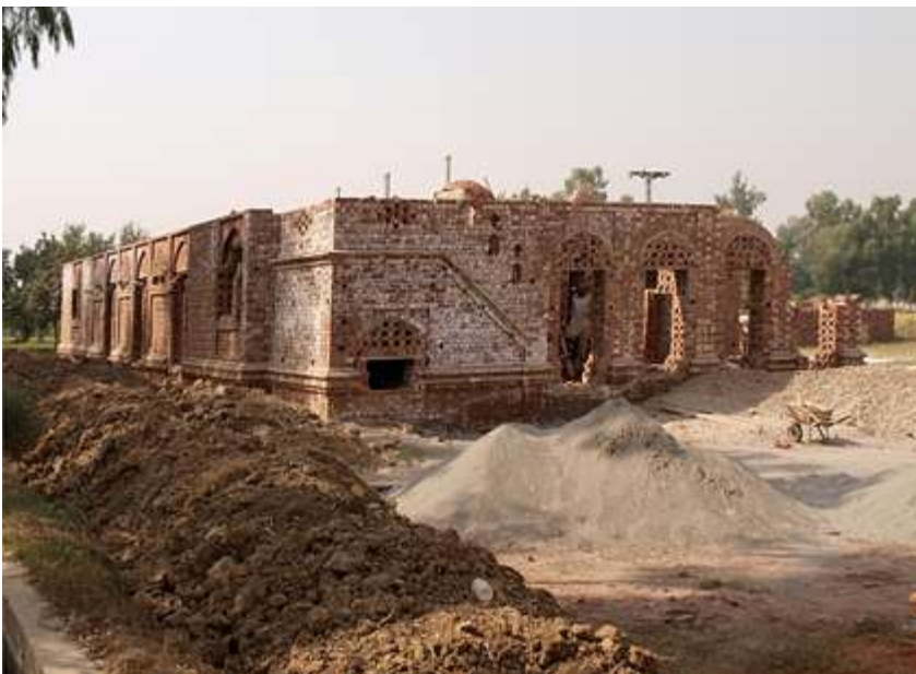
Construction of the east elevation and the north courtyard elevation of the residence | Construcción del alzado este y del alzado norte del patio de la residencia | Construção do alçado nascente e do alçado norte do pátio da residência
